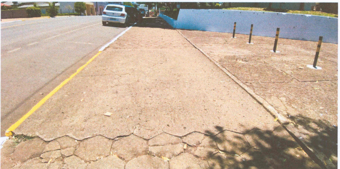
Figura 5: Detalhe de pavimento de concreto existente, em rampa de entrada de veículos. Deverá ser retirado para execução do paver. Coordenadas: 28°22'14.44"S; 51°38'15.40"O.
