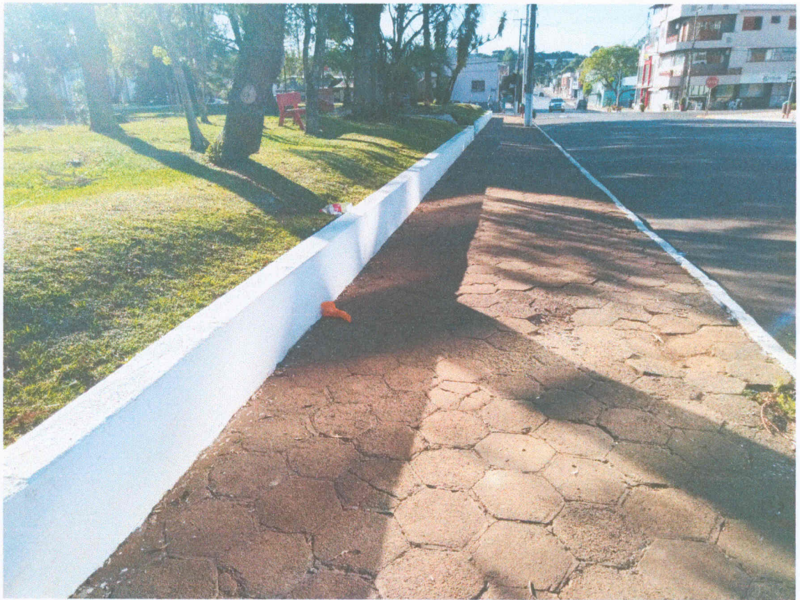
Figura 8: Vista do passeio existente na Rua Frei Aleixo, que será retirado e substituído por paver. Coordenadas: 28°22'12.62"S; 51°38'12.82"O.
