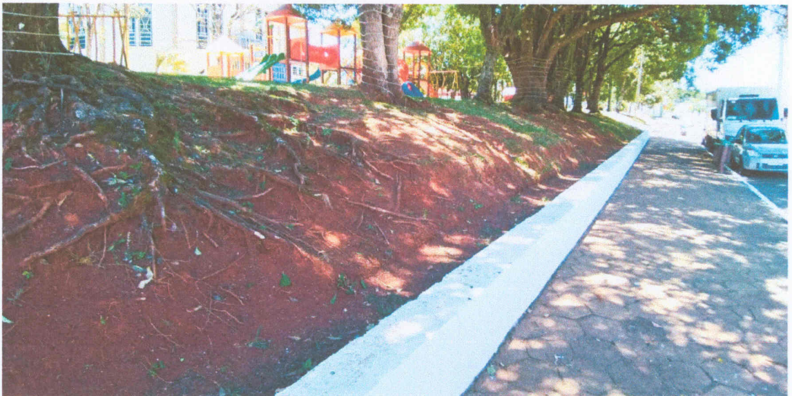
Figura 7: Muro de contenção existente em frente à Rua Augusto Pomatti, onde será construído muro de concreto "muroflor". Imagem mostra área que será escavada para construção da sapata do muro. Coordenadas: 28°22'15.36"S; 51°38'15.13"O.
