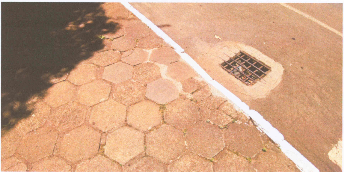
Figura 9: Detalhe de uma das bocas de lobo existentes. Coordenadas: 28°22'15.21"S; 51°38'15.69"O.
