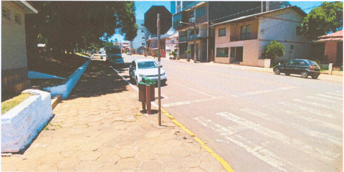
Figura 6: Vista do passeio existente na Rua Augusto Pomatti. Imagem mostra também lixeira e placa que precisarão ser retirados para execução da obra e posteriormente reinstalados. Coordenadas: 28°22'15.25"S; 51°38'15.61"O.
