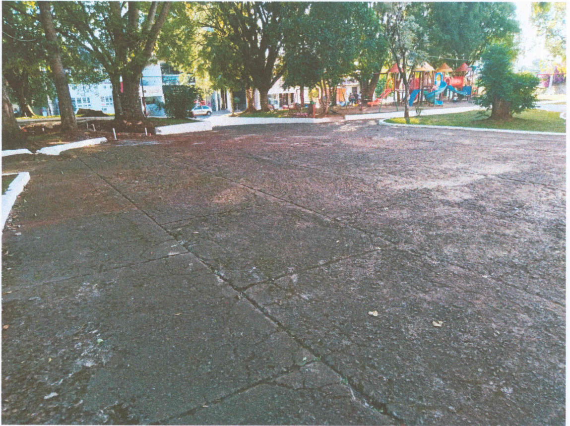
Figura 4: Detalhe do pavimento de concreto existente, que deverá ser retirado. Coordenadas: 28°22'15.00"S; 51°38'13.50"O.
