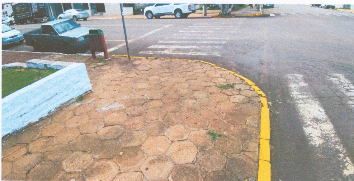
Figura 1: Esquina entre as ruas Longino Zacharias Guadagnin (à direita) e Rua Augusto Pomatti (à esquerda). Mostra o pavimento existente passeio público existente, que deverá ser retirado para posterior execução de piso intertravado (paver) e rampas de acessibilidade. Também é mostrado o pavimento asfáltico existente, onde será feita repintura de faixas. Coordenadas: 28°22'15.05"S; 51°38'15.71"O.
