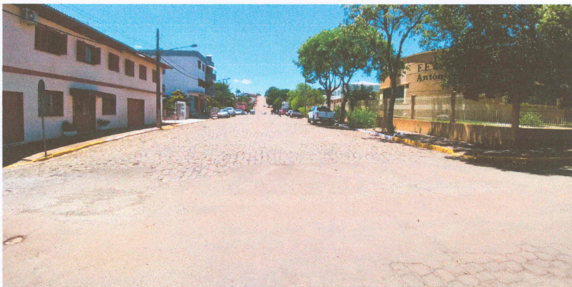
Figura 10: Rua João Stella, vista da esquina com a Rua Longino Zacharias Guadagnin. A rua João Sella (à frente) passa em frente à Prefeitura Municipal e receberá pavimentação em asfalto. Coordenadas: 28°22'22.12"S; 51°38'20.16"O.
