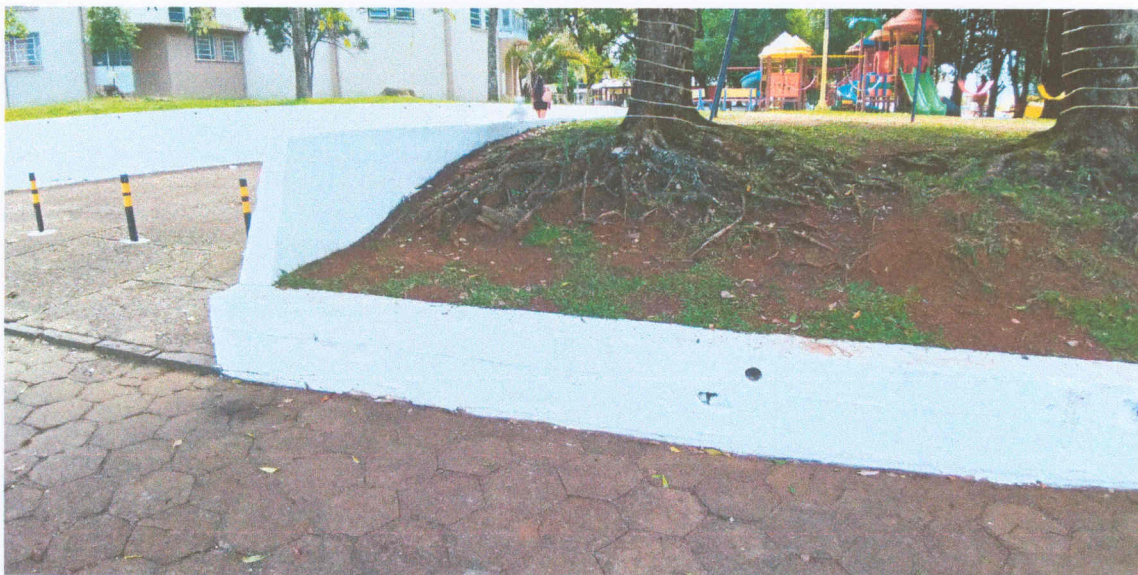
Figura 2: Muro de contenção existente, onde será construído o muro de concreto "muroflor". Imagem mostra piso existente que deverá ser retirado para posterior instalação do paver. Coordenadas: 28°22'14.44"S; 51°38'15.40"O.
