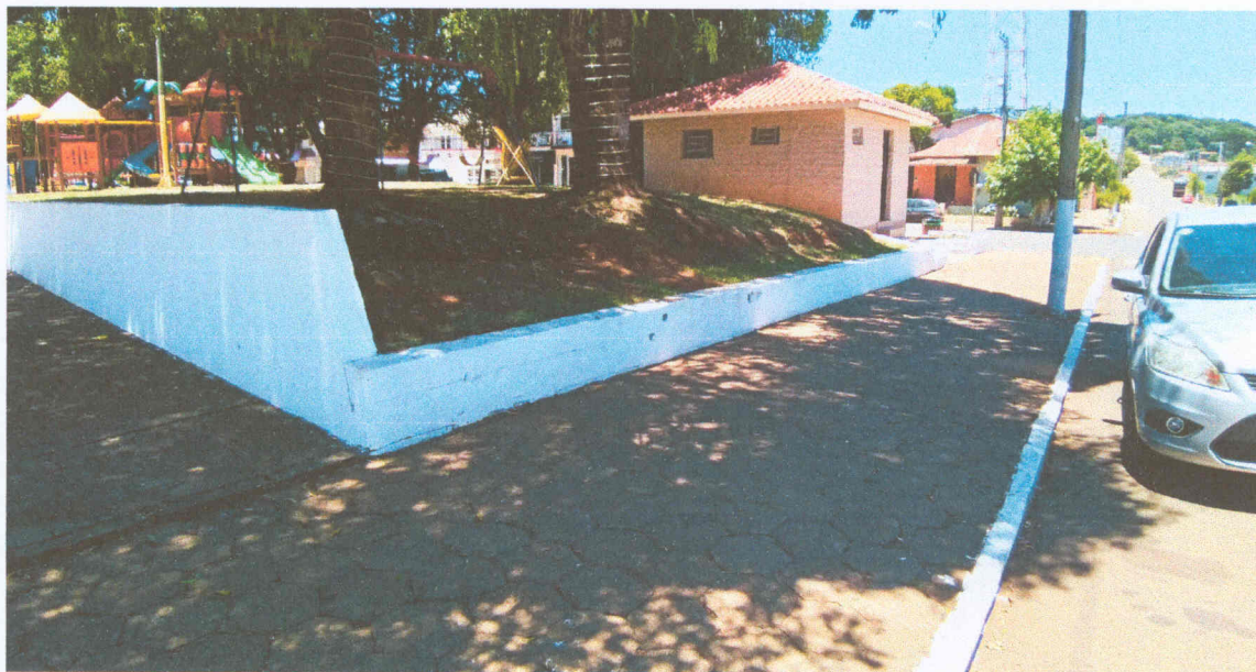
Figura 3: Mesmo trecho de muro de contenção existente, já mostrado na Figura 2. No muro alto (à esquerda) será instalado guarda corpo. Coordenadas: 28°22'14.44"S; 51°38'15.40"O.
