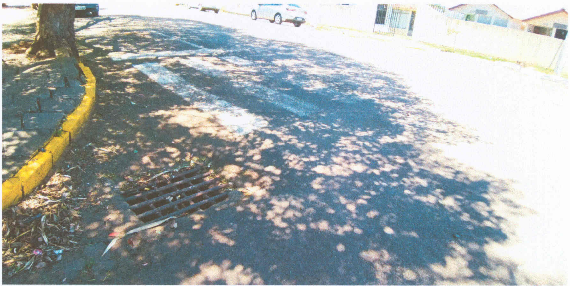
Figura 12: Detalhe de boca de lobo existente na esquina entre as ruas Longino Z. Guadagnin e João Stella. Também é possível ver local onde será feita repintura da faixa de pedestres. Coordenadas: 28°22'22.52"S; 51°38'20.27"O.
